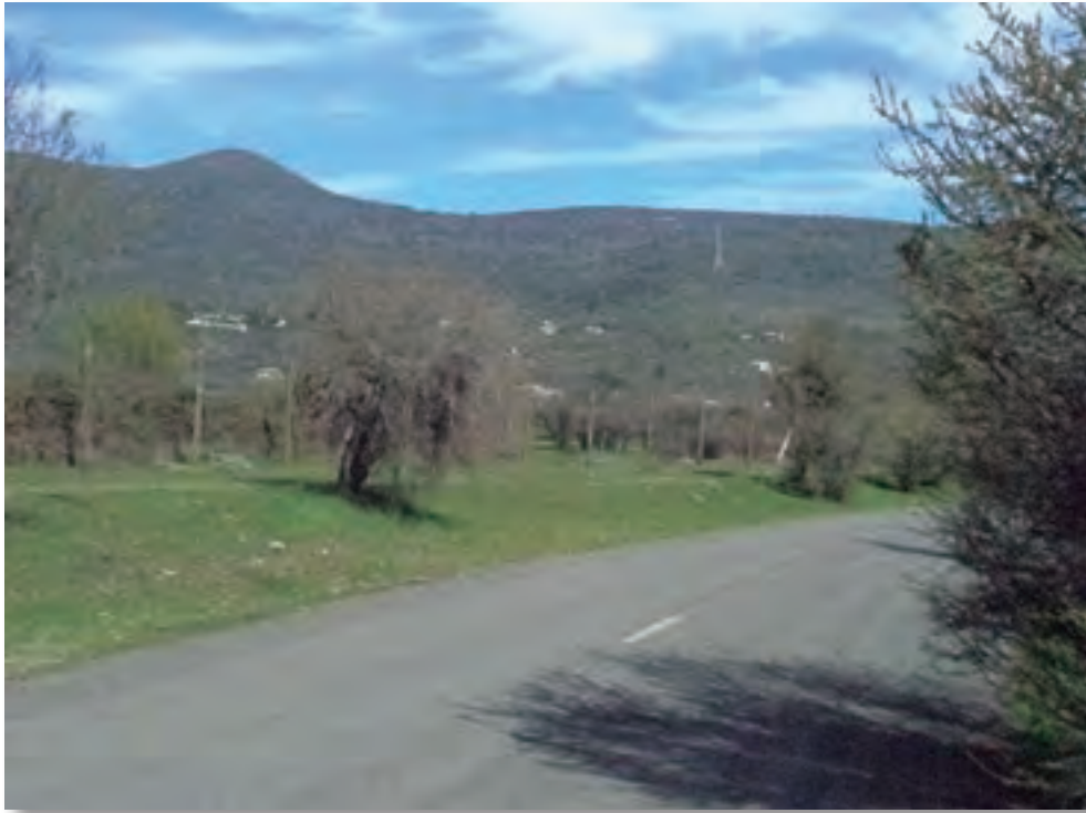
Tendido eléctrico de alta tensión Hidroeléctrica Pacific Hydro, sector Sierra Nevada, Machalí
