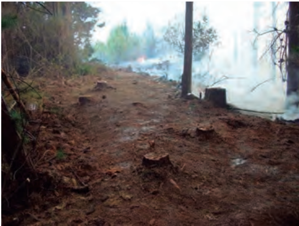
Cortafuego en plantación de pinos realizado para detener la propagación de un incendio forestal en la Provincia de Cardenal Caro
