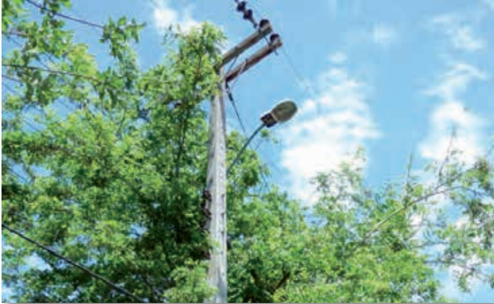
Tendido eléctrico con presencia de vegetación
